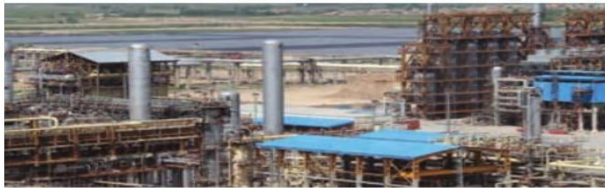
شکل ۴- نمایی از یک برج تقطیر برای جداسازی اجزای هوا در پتروشیمی اهواز
